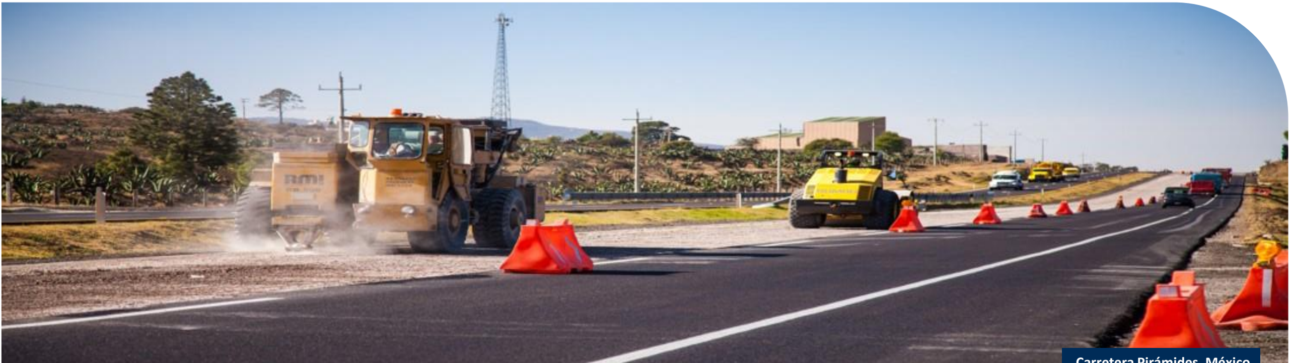
Carretera Pirámides, México
