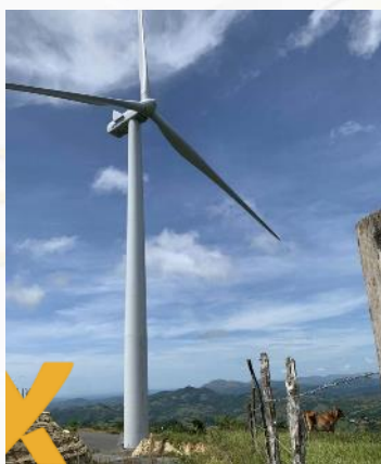
Parque eólico Toabré (Panamá) 66 MW
