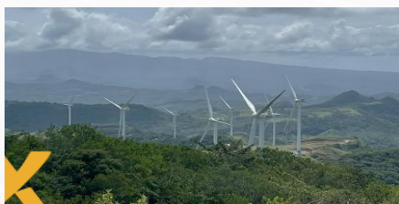
Parque eólico Toabré (Panamá) 66 MW
