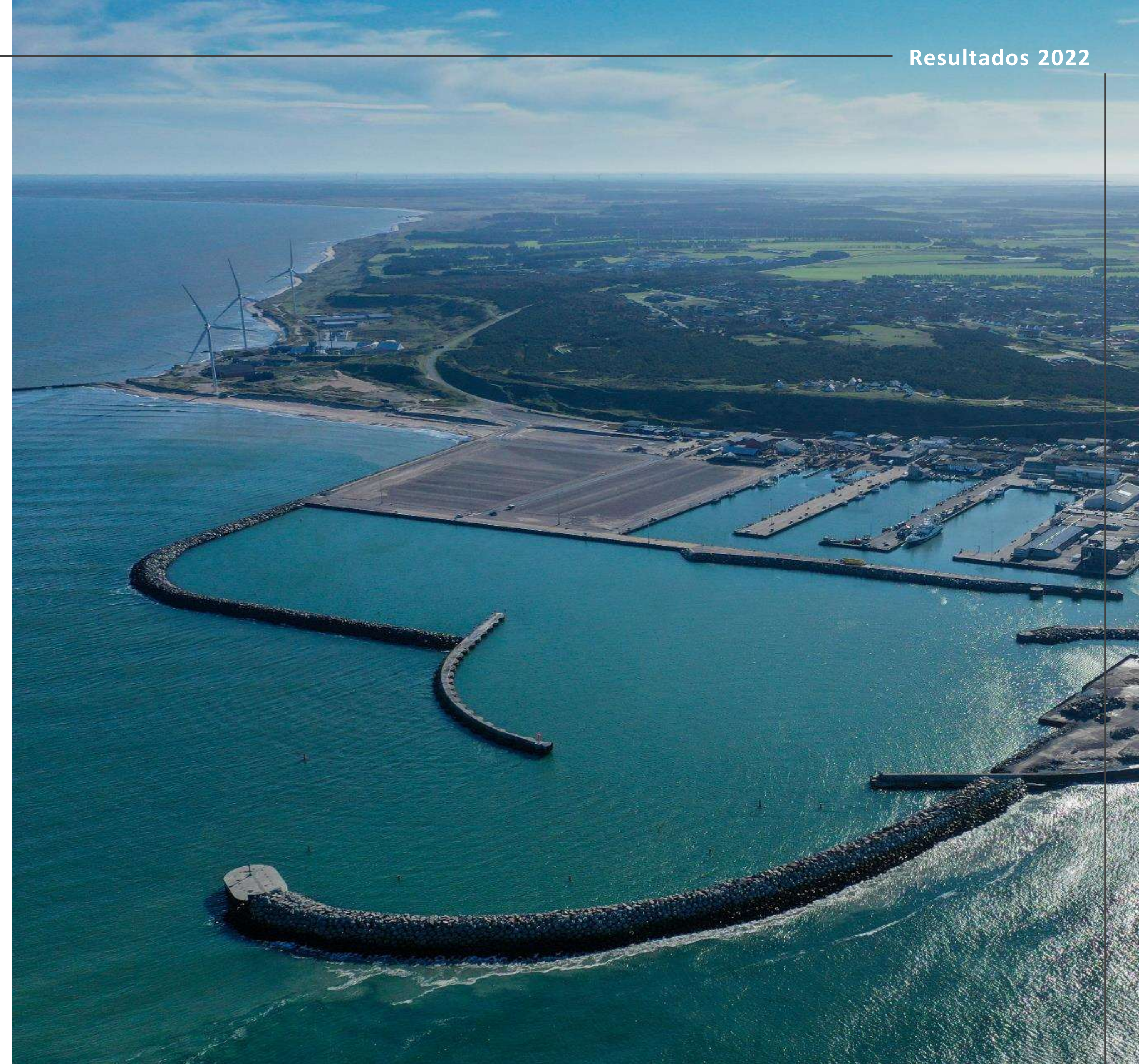
Dique oeste - Expansión del Puerto de Hanstholm. Dinamarca.
