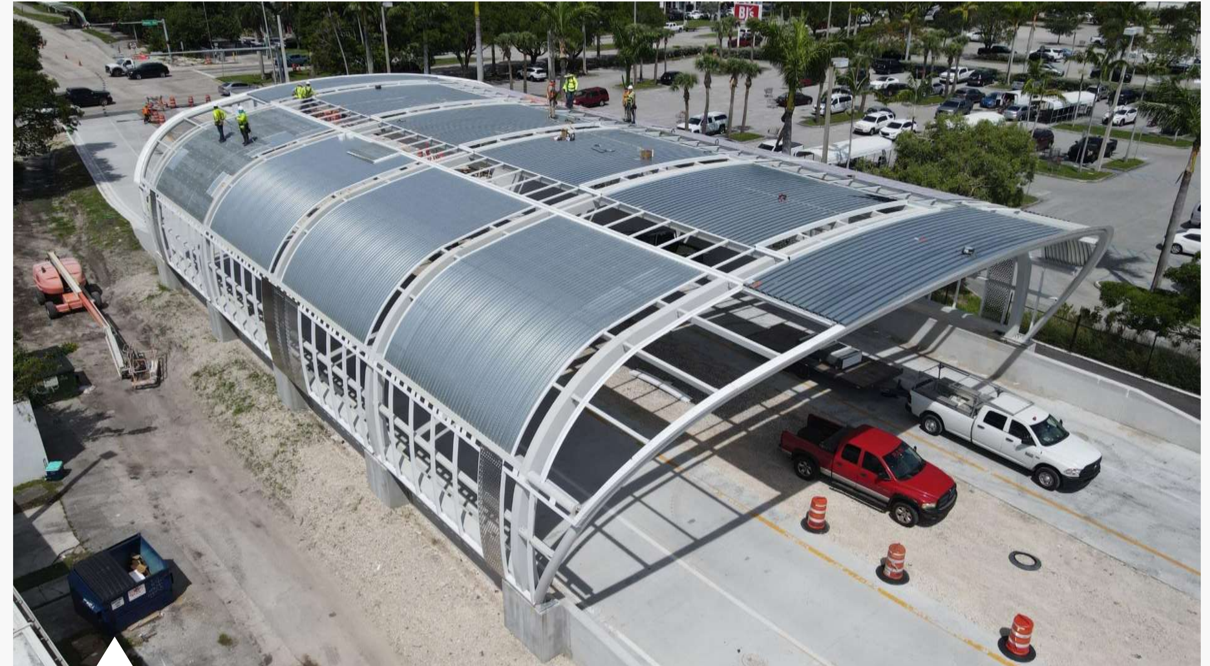
South Corridor Bus Rapid Transit, condado de Miami-Dade, Florida, EE.UU.
