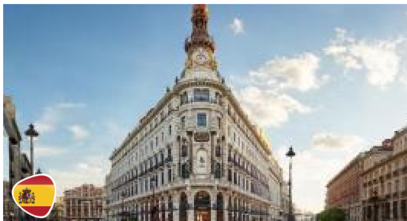
Canalejas. Desarrollo urbano que potencia un modelo de ciudad alineada con la Agenda 2030
