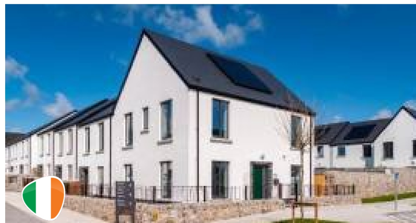
Social Housing Bundle 2. Proyecto PPP centrado en la construcción de 465 viviendas sociales sostenibles
