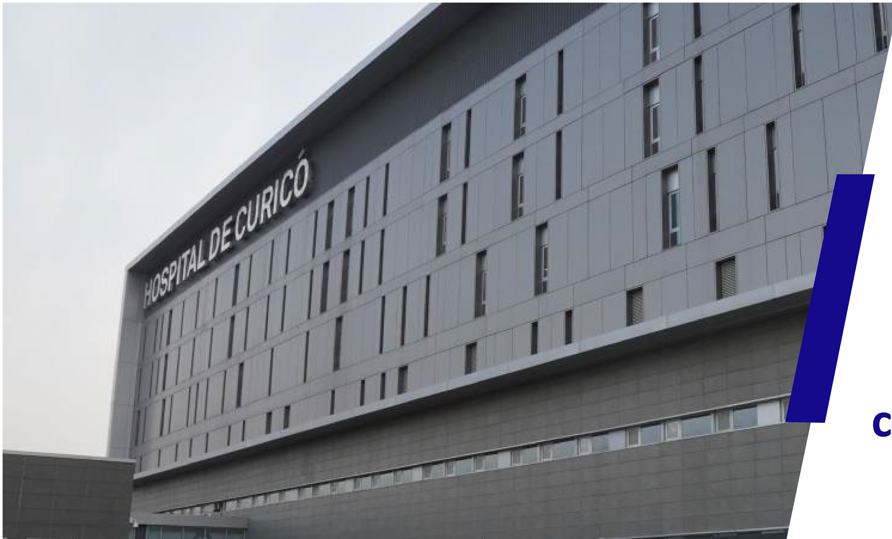
Hospital de Curicó. Chile
