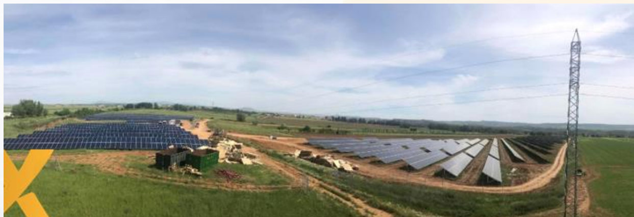
Planta fotovoltaica de Cañamares en Guadalajara
