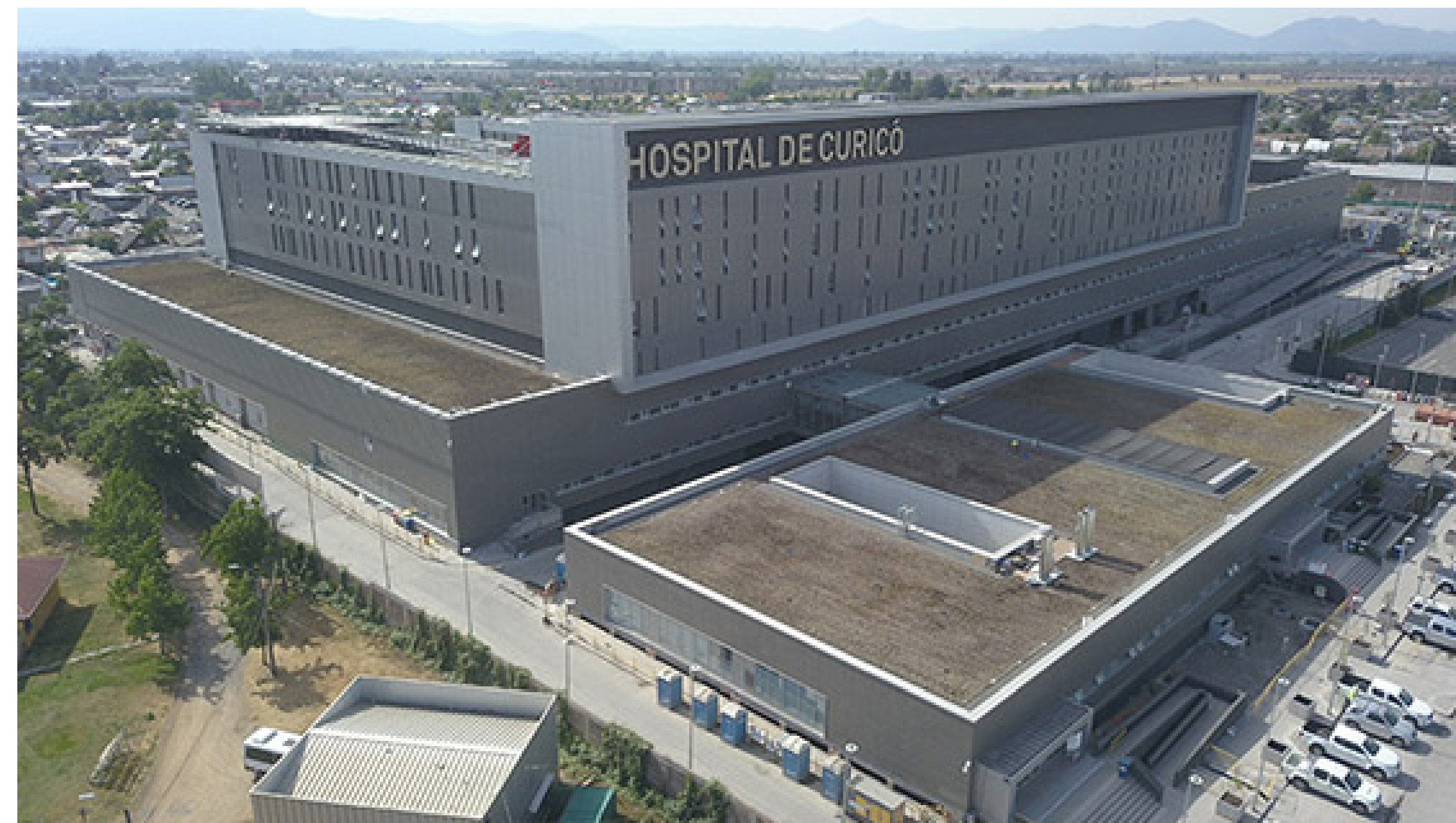
Hospital de Curicó. Chile
