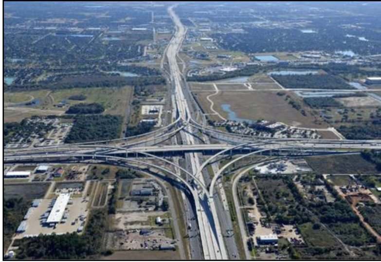
Nuevos carriles de peaje gestionados construidos en la mediana de la autopista SH-288
