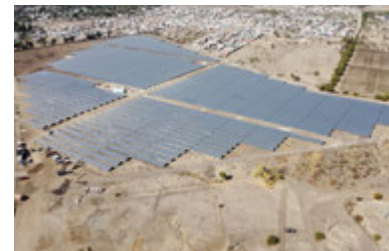
Sol de Septiembre 10MW
