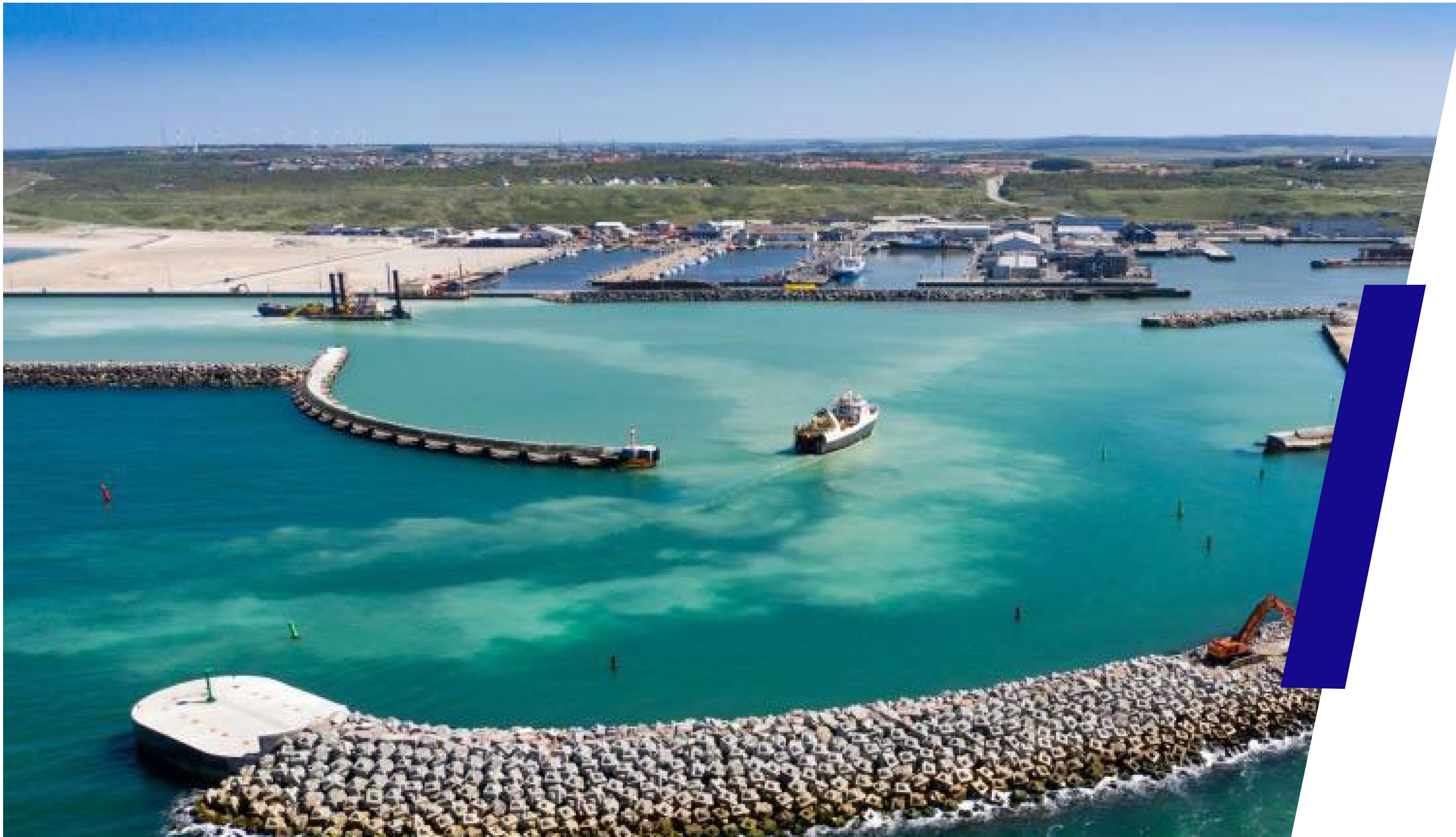
Puerto de Hanstholm. Dinamarca. Infraestructura donde se emplea la tecnología de OHLA, Cubipod
