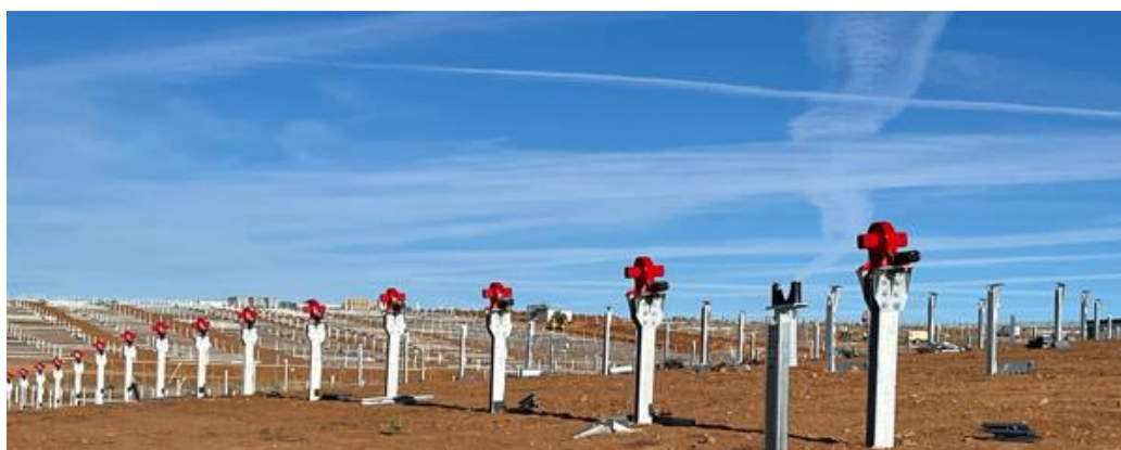
Construcción de las plantas Cuatro Caminos 1, 2, 3 y 4.
