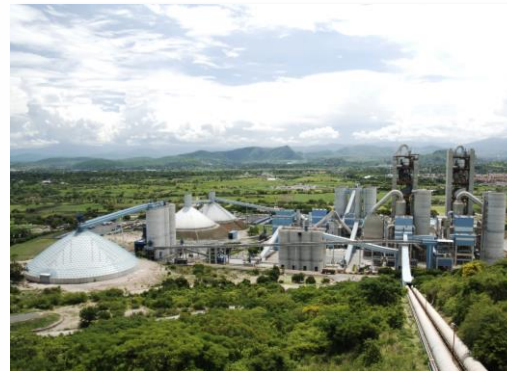
Incremento de capacidad en la planta Tepetzingo (México)
