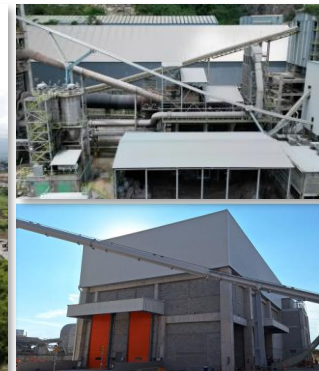
Nuevas instalaciones de combustibles alternativos en México y Colombia
