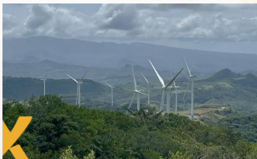
Wind farm Toabré (Panamá) 66 MW
