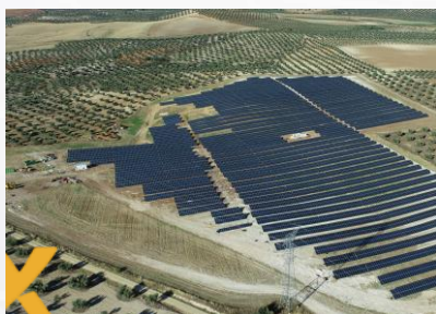
PV El Toconal (Toledo) 5 MWp
